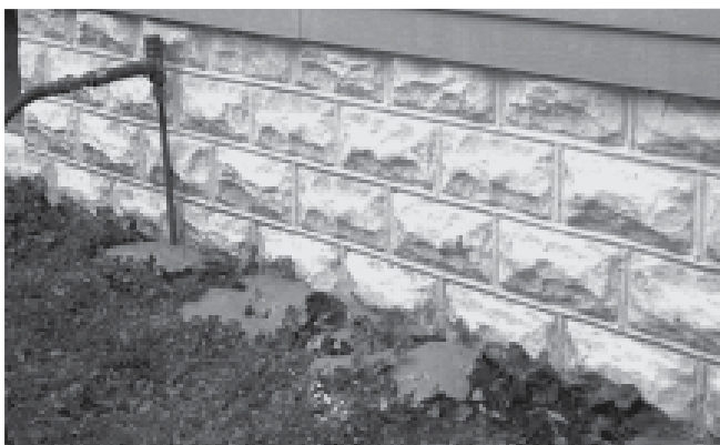
APLICACIÓN EN MUROS EXTERIORES DE MAMPOSTERÍA: Inyectar BEN TOGROUT® a lo largo del exterior de un muro de cimentación con una separación de 600 mm centro a centro
