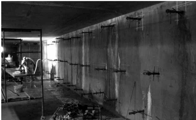
INYECCIÓN DE LECHADA EN SUPERFICIE INTERIOR: BEN TOGROUT® se aplica en el interior del edificio sin excavar el emplazamiento
